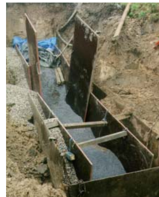
Figur 8. Tidligere har man bygget store 'jernmure' for at rense grundvandet for forurening. I dag kan nanopartikler af jern pumpes direkte ned i undergrunden uden gravearbejde.
